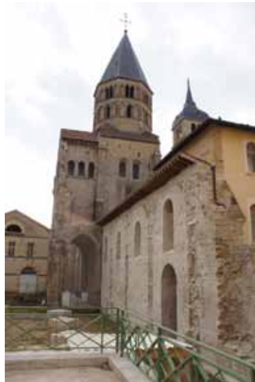
Reste der einstigen Abtei
